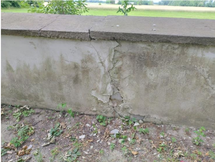
Stan ogrodzenia z tyłu za kościołem
